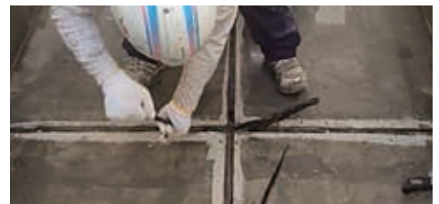
既存目地材のキャップを撤去
