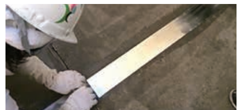
ゴムローラーによる転圧
