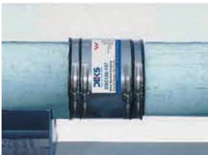
シェアバンドにより、管を水平に保ちます
