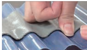
実際に波板へ施工している様子
