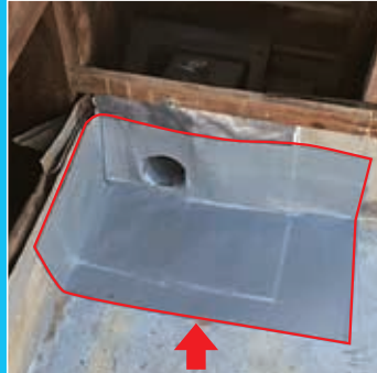
ドレン周りの補修
