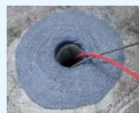
縦型ドレンの補修に
