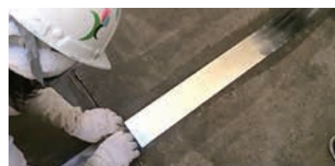
ゴムローラーによる転圧
