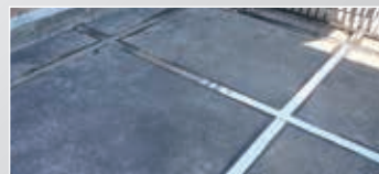
ウレタン防水(通気緩衝工法)下地処理
