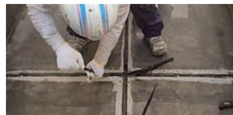
既存の目地材を覆うキャップの撤去
